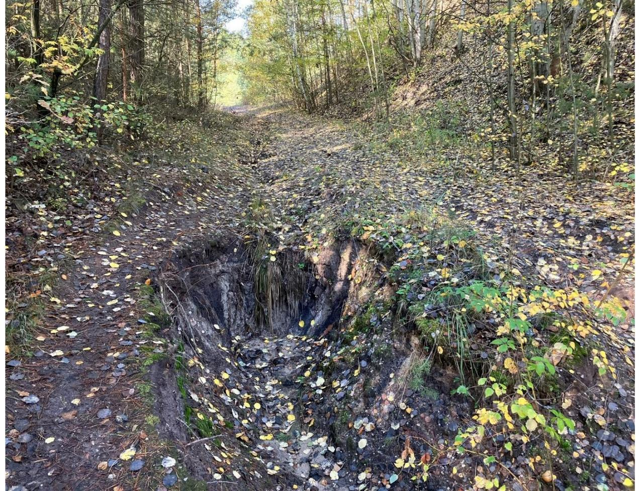
**Abb.:** Tagbruch infolge des Einsturzes unterirdischer Hohlräume (Strecken und Stollen) auf einem Waldweg oberhalb der ehemaligen „Grube Agnes“, Quelle: DMT GmbH & Co. KG
