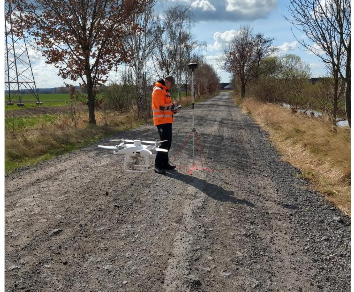
**Abb.:** Vermessung mittels Drohnenbefliegung auf den Freiflächen der B169 OU Elsterwerda, Quelle: Ingenieurbüro Bertels GmbH
