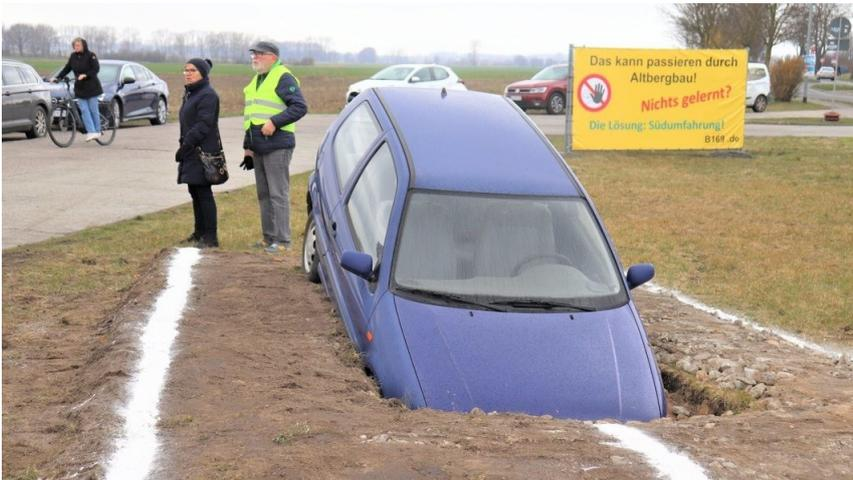
Was passieren könnte: Direkt neben der B 169 am Ortseingang in Plessa aus Richtung Elsterwerda ist dieses Auto halb in einer Straße verschwunden, die auf einer nicht vollständig gesicherten Trasse über Altbergbaugelände führt.
